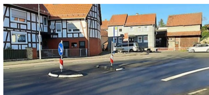
Eine Querungshilfe mit Tücken für gehbehinderte Menschen, weil die Bordsteine nicht passend abgesenkt sind. Foto: Götz Schaub
